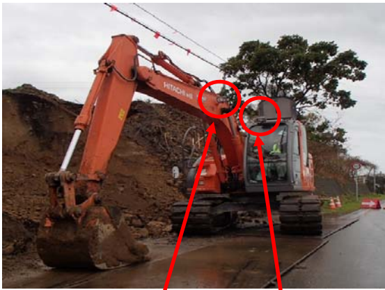
架空線損傷対策
